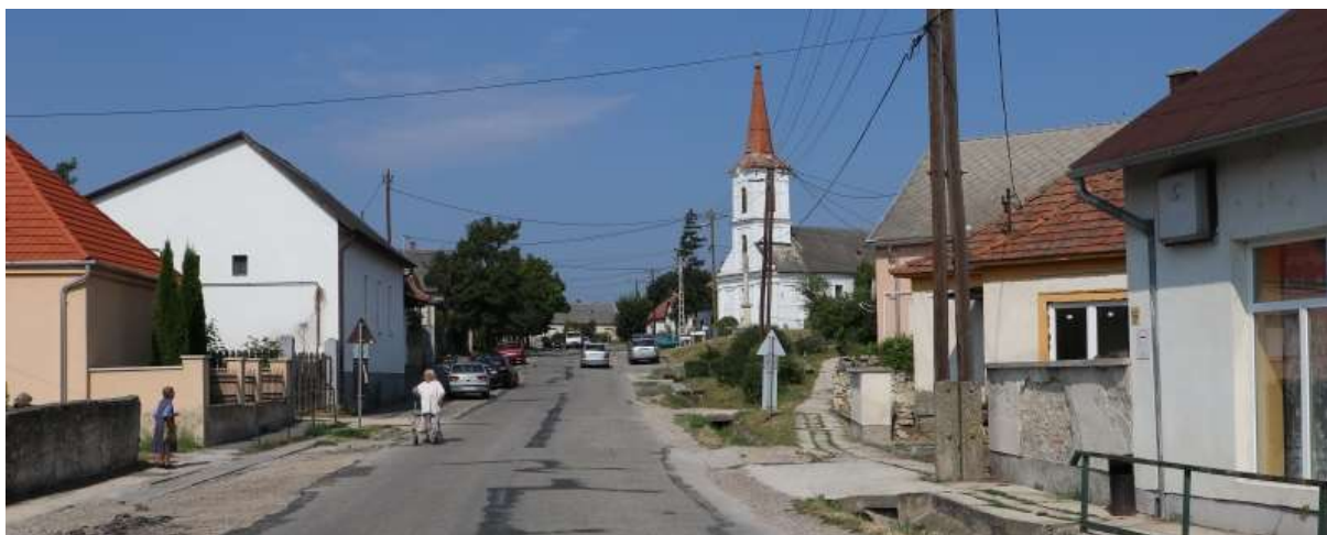
Fő utca nyugati irányban vegyes beépítéssel
